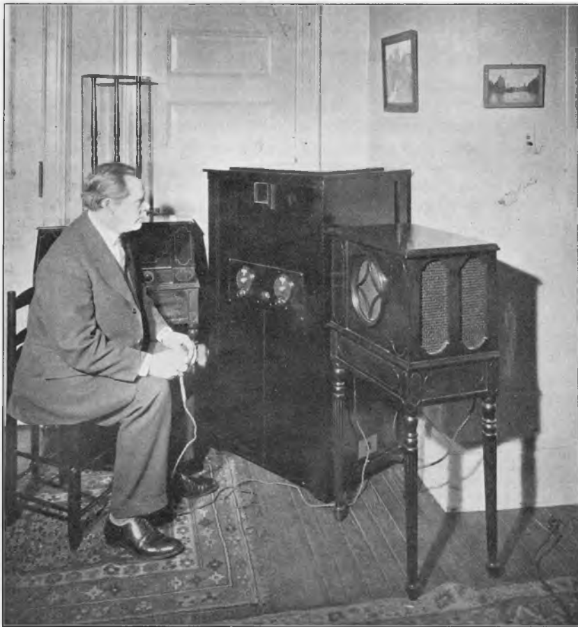
Dr. E. F. W. Alexanderson voor zijn apparatuur. Achter hem een omroep-ontvanger, in het midden de televisie-ontvanger en geheel rechts de Rice-Kellog luidspreker, een electro-dynamisch instrument met ingebouwd versterker.
